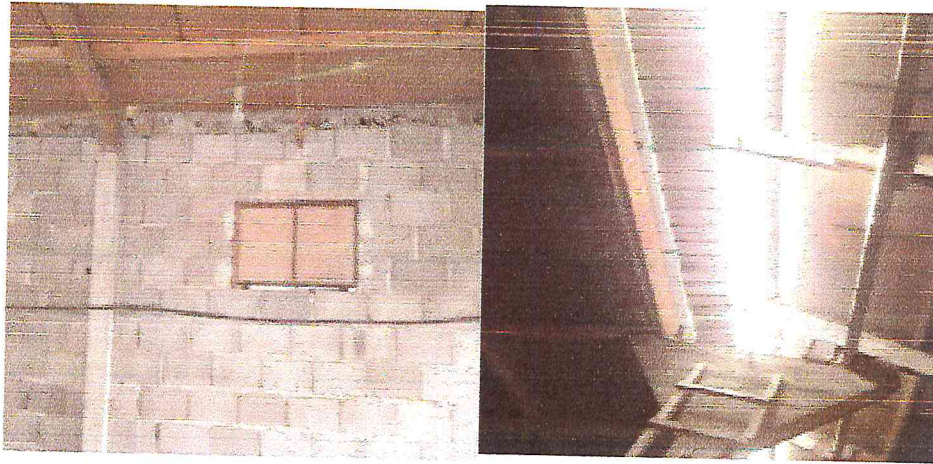
Figure 6: Système d'aération : fenêtre et lanterneau( photo personnelle)
