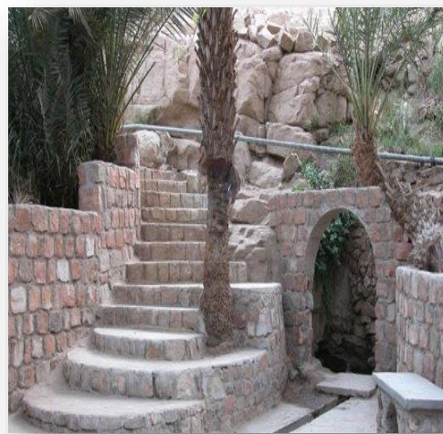
Source d'eau à Adjahil nappe de TELMZAIS
