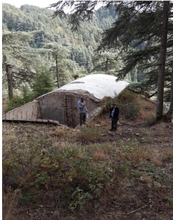
Figure III-7 : Vue bâche à eau sans dalle de couverture et de l' armoire électrique
