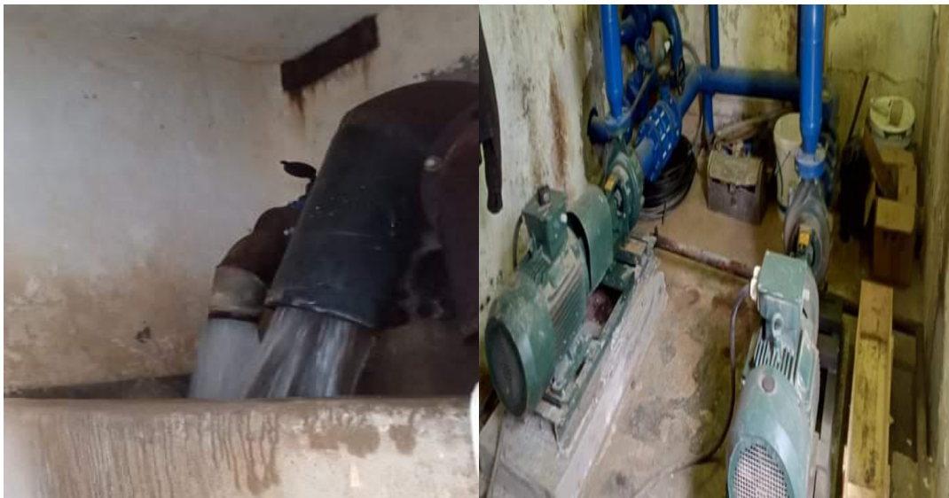
Figure III-3: Photo de la station de pompage et d'adduction d'eau de source au réservoir Trois moineaux
