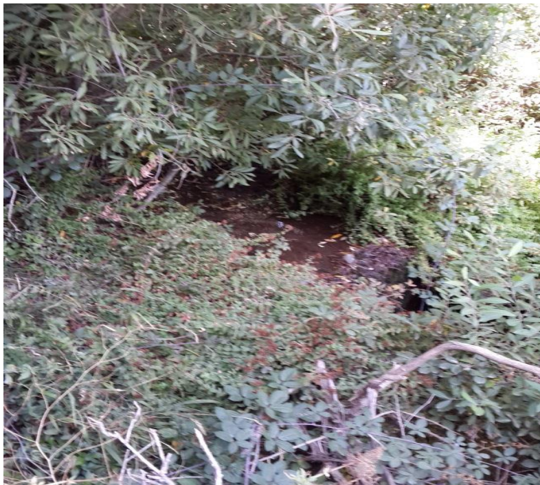
Figure IV-10 : Digue de captage entièrement envasé
