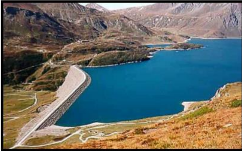
Figure I.7 : Barrage en terre
