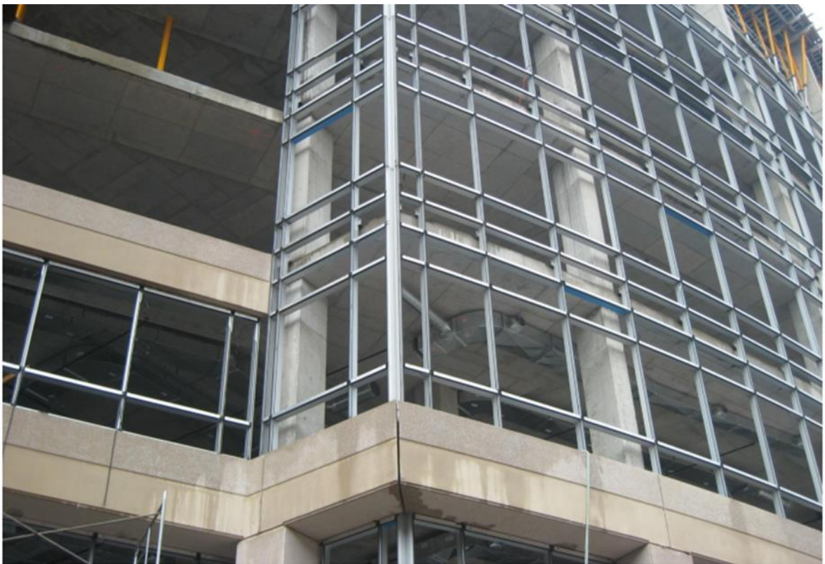
Figure 3.8- Mise en place par système à résille
