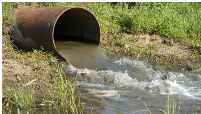
Figure 1 : Conduite d'eau usée
