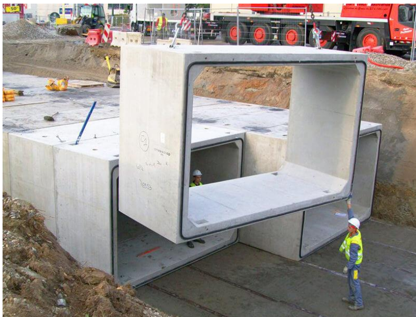
Figure 9 : conduites en béton sous forme de dalot
