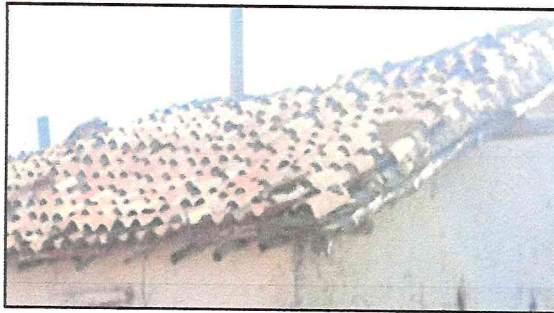
Photo14 : Toiture recouverte du côté extérieur par la tuile.
