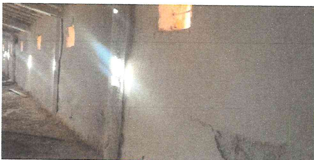
Photo20 : Les fenêtres du bâtiment.
