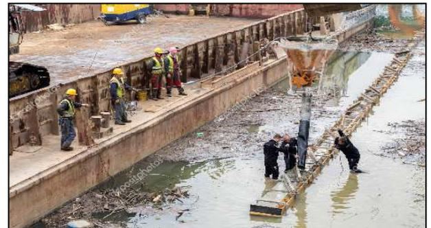
Figure I.22 : bétonnage sous l'eau .
