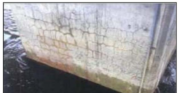
Figure I.16 : Dégradation due à l'alcali-réaction.
