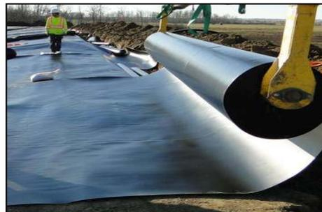
Figure I.25: Géomembrane.
