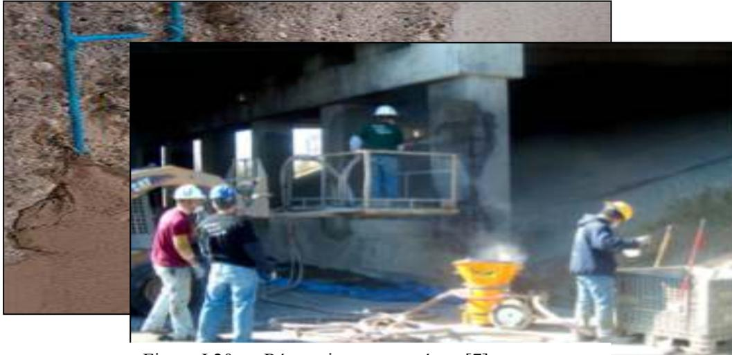
Figure I.20.a : Réparation par ragréage [7]
