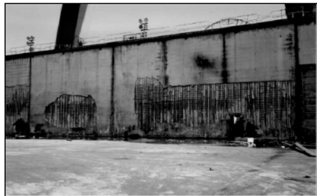
Figure I.18.b : Détérioration du Quai après 20 ans d'exposition.
