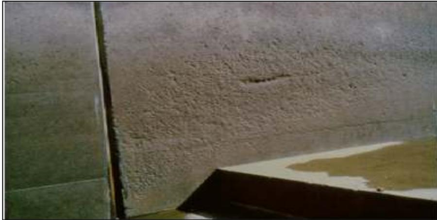
Figure I.15 : Dégradation mécanique due au frottement.
