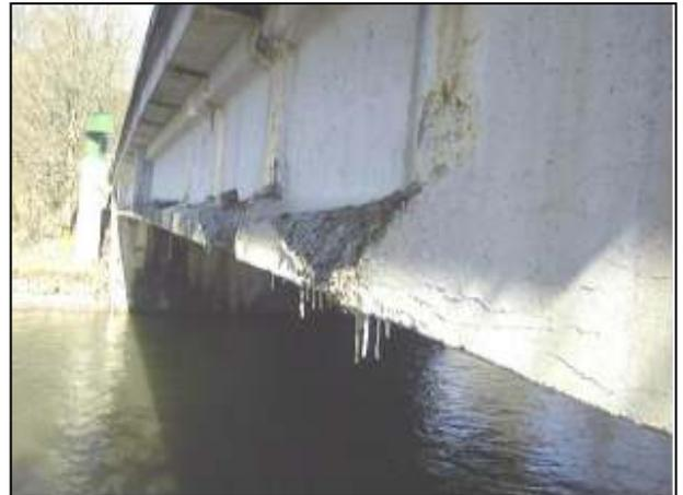
Figure I.17: fissurations dues au gel-dégel.
