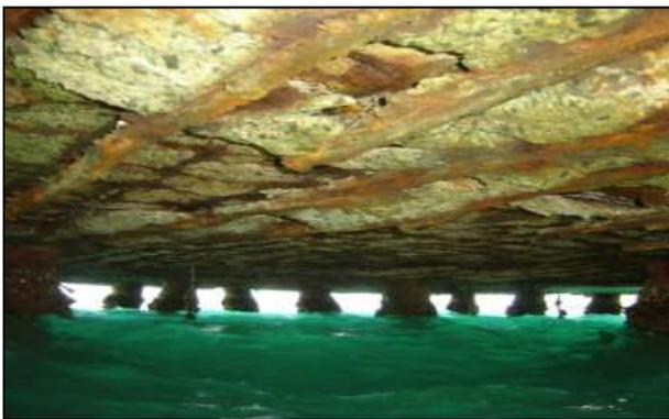
Figure I.18.a : éclatement du béton dus a la corrosion des armatures.
