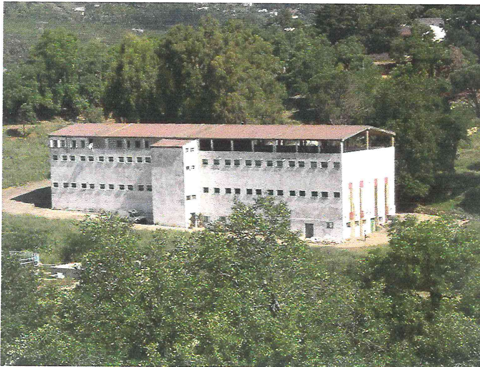
Figure(3): un bâtiment en Tunisie, des années 80 avec 2 étages d'élevage en fosses 1/2 profondes et l'habitation de l'éleveur au dessus .(Lebas, 2009)
