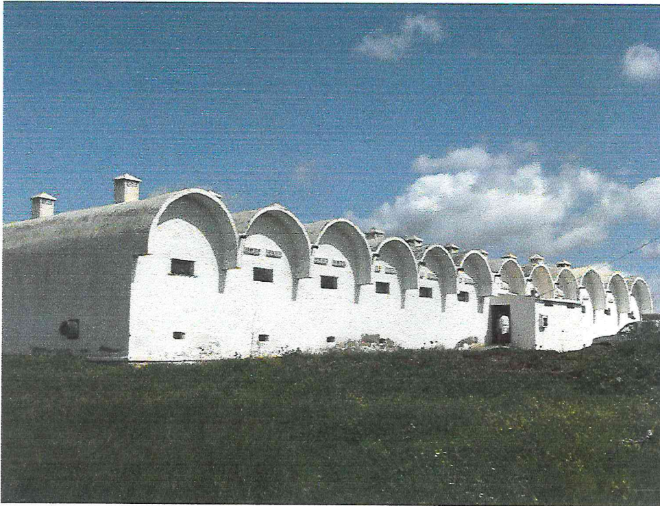
Figure(2): Bâtiment avec toiture en voûte en Tunisie (Lebas, 2009)
