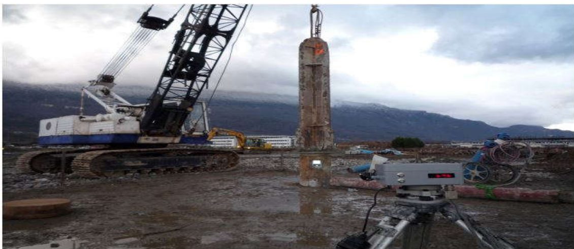
Figure 1.16 : Essai de chargement dynamique avec théodolite SIMBAT.
