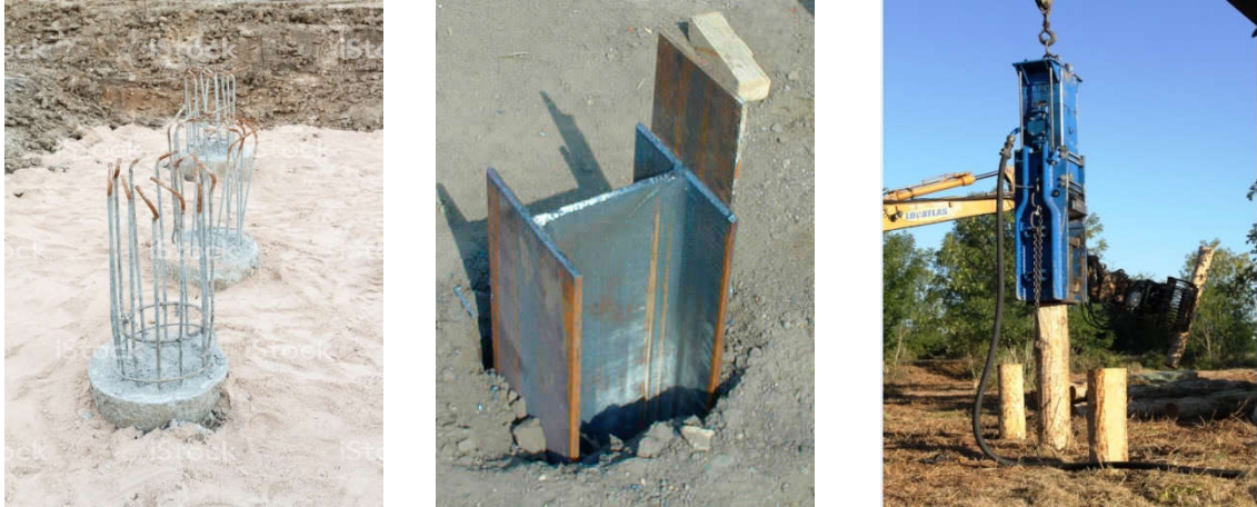
Figure 1.2 : Différents types de pieux selon le matériau de réalisation (Béton, Acier, Bois)
