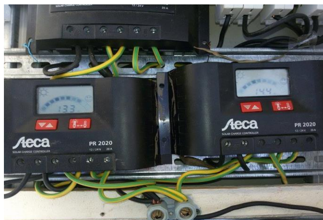
Figure VII.3: Régulateurs de charge 12V /20A
