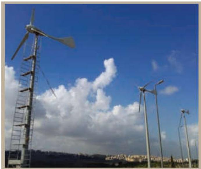
Figure 1.5. Trois éoliennes JIMP 25kW des Grands Vents (2006). [6]
