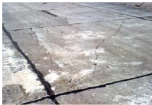
Figure 1.8 Les fractures dans les chaussées rigides
