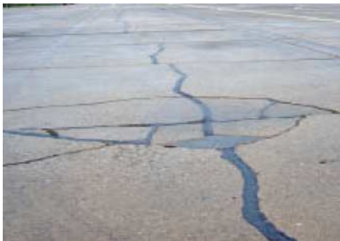
Figure 1.8 Les fractures dans les chaussées rigides
