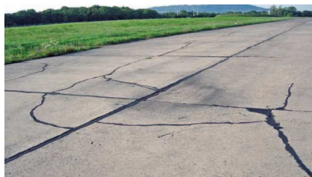
Figure 1.9 Pompage dans les chaussées rigides
