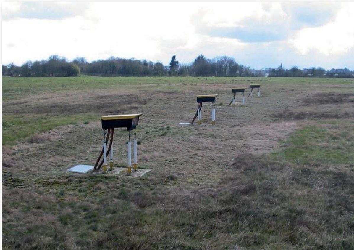
Photo d'un PAPI installé sur un sol en pente. Pour compenser la pente et afin que les unités soient positionnées selon les tolérances décrites ci-dessus, chaque unité du PAPI est positionnée à une hauteur différente.
