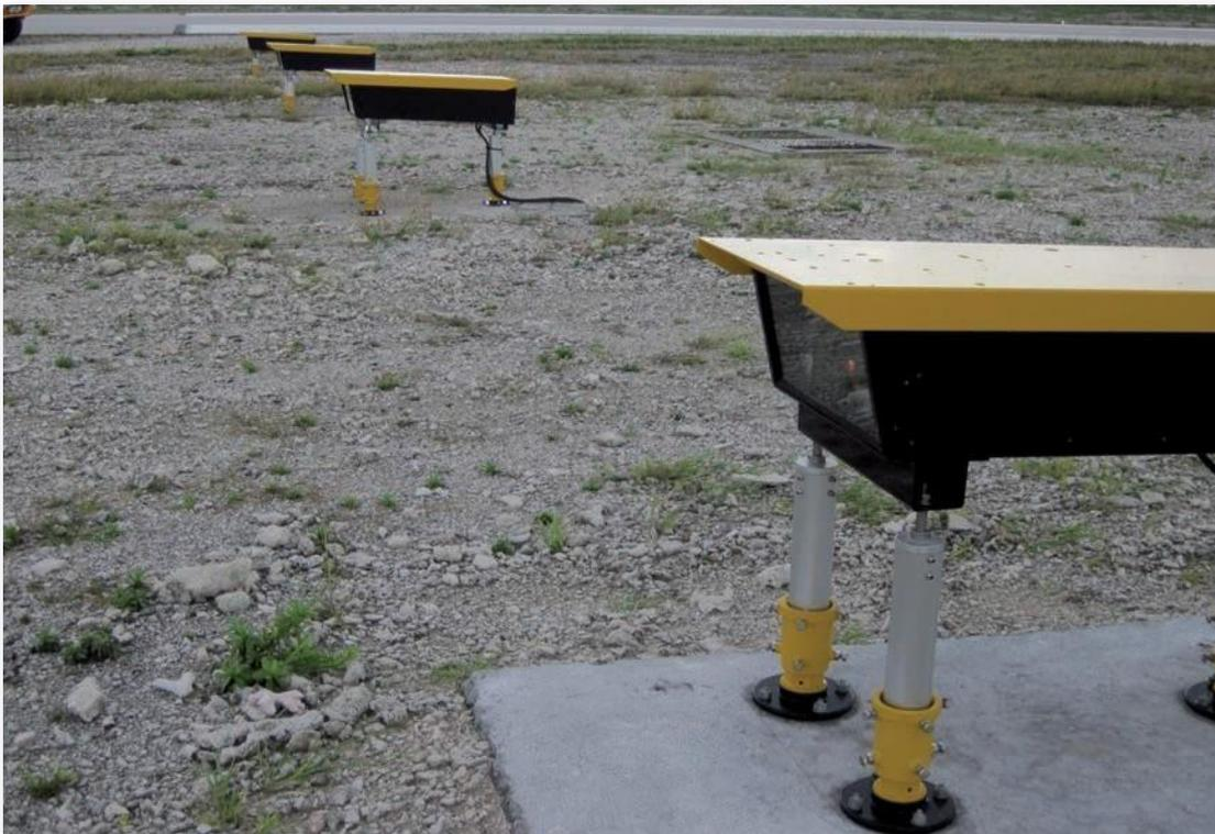
Enfin, afin d'assurer une perception optimale du signal du PAPI par les pilotes, les unités lumineuses sont calées en azimuth parallèlement à l'axe de piste avec une tolérance de  $\pm 1^\circ$ , soit  $\pm 1,75$  cf schéma ci-dessous).
