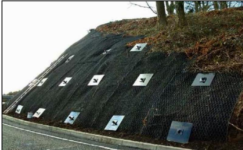
Figure. III.8 : Photo d'un versant stabilisé par clouage
