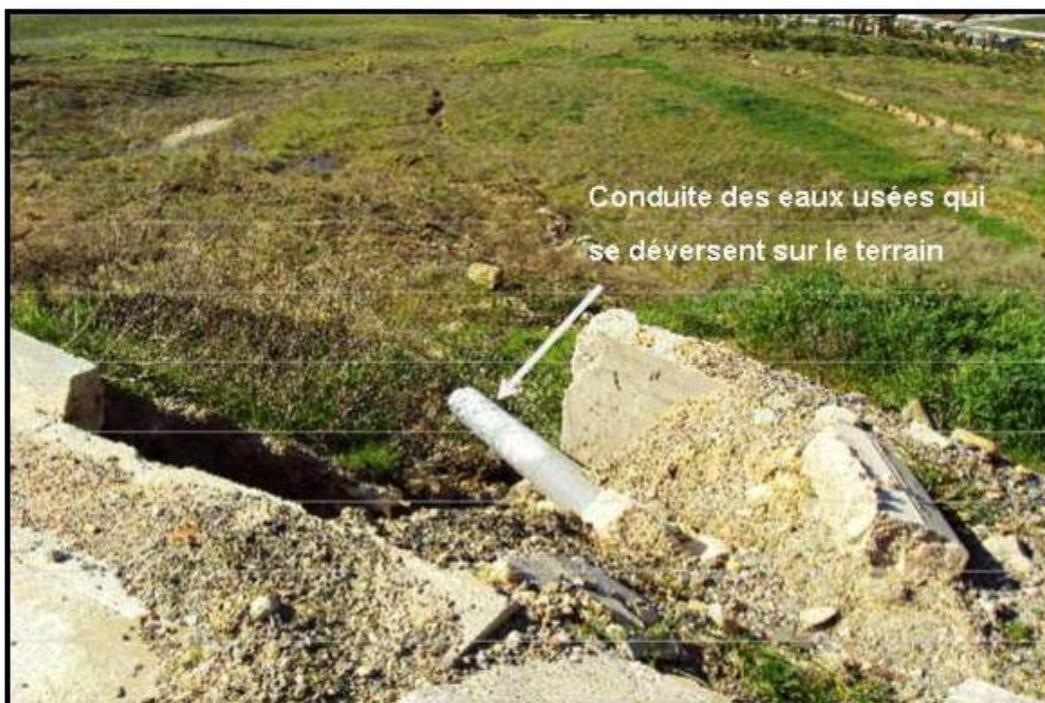
**Figure IV. 10:** Le diversement des eaux pluviales et d'assainissements dans le talus.
