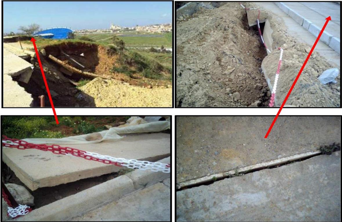
**Figure IV. 5 :** Affaissement important de la chaussée et fissures de tractions sur l'accotement de la route.
