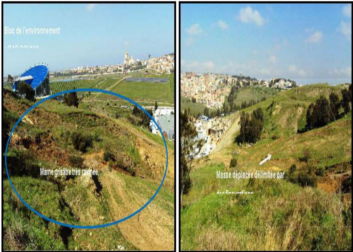
Figure IV. 7 : Déplacement et déformation de la couche du remblai
