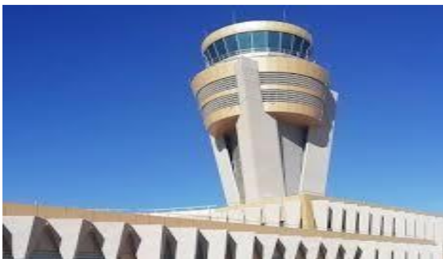
Figure 1. 13 : La nouvelle tour de contrôle de l'aéroport de Ghardaïa.
