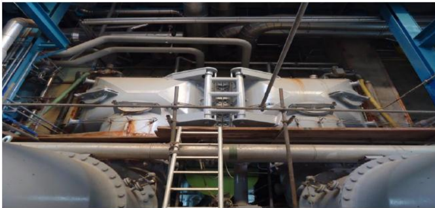
Figure I.2 : Le condenseur.
