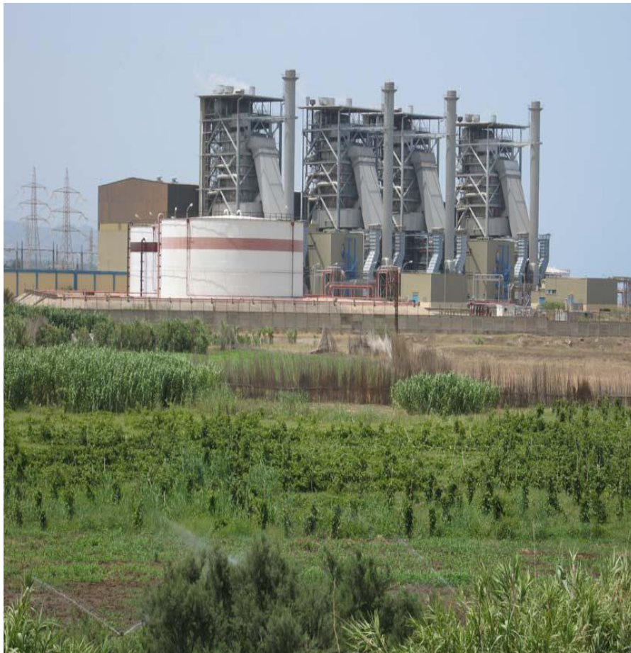
Figure I.1 Vue de la centrale de Cap-Djinet
