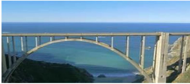
Figure I.3 : Pont en arc
