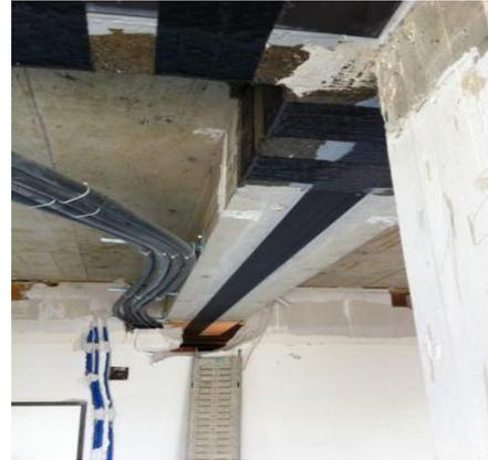
**Figure I.12:** poutre renforcée par TFC [3].
