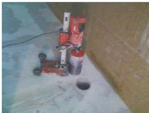
**Figure I.5 : Le carottage de béton [3]**
