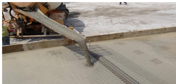
Figure I.14. Coulage d'un béton autoplaçant.
