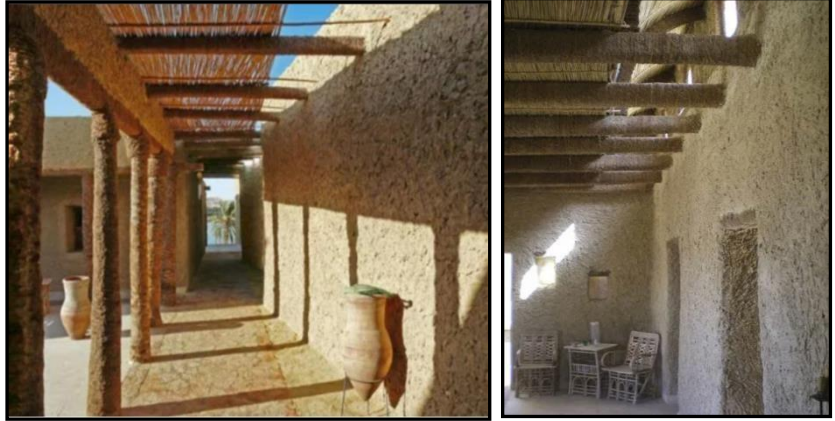
Figure 3.3: Images qui montre les murs construits en matériau traditionnel le « Kershef »
