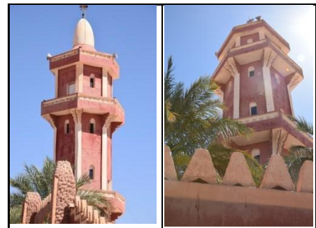
Figure 4.34 : Minaret d'une mosquée à Timimoun
