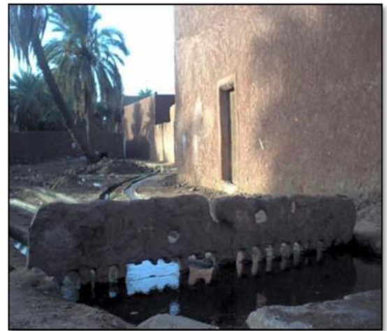
Figure 4.17 : Kessria de la grande foggara El Megheir à Timimoun.
