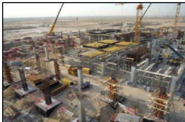
Figure 2.13 : les aciers recyclés dans la construction
