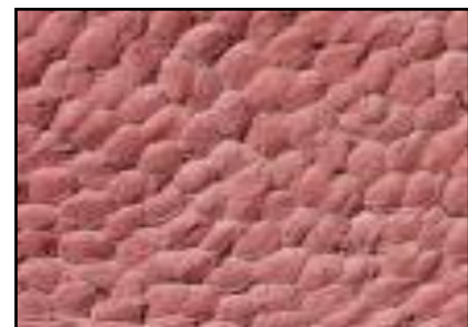
Figure 3.23: Enduit en méthode tboulit
