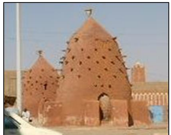
Figure 4.18 : Coupole protégeant les bouches D'aération de la foggara El Megheir. Source : photo prise par les étudiants lors de la visite d'études sur Timimoun Mars 2020
