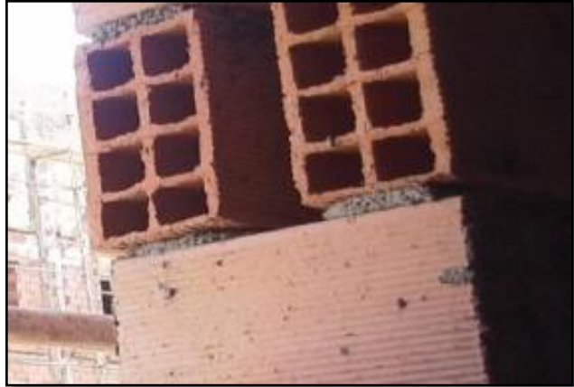
Figure 57: Détail de mur extérieur
