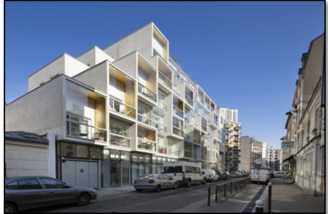
Figure 100: façade du logement plein soleil
