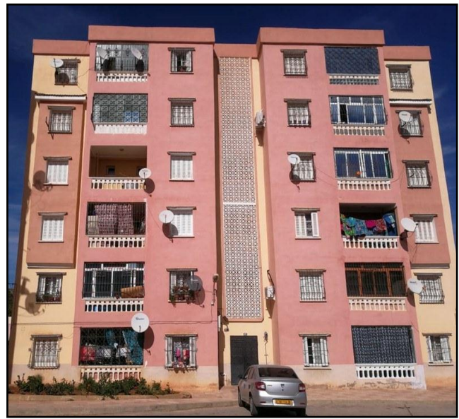
Figure 54: Façade principale après les modifications
