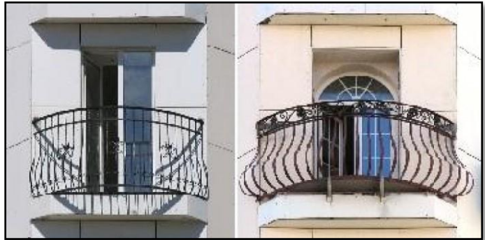
Figure 2: Balcon en fer forgé
