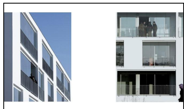
Figure 106: Vue de la loggia depuis la rue
