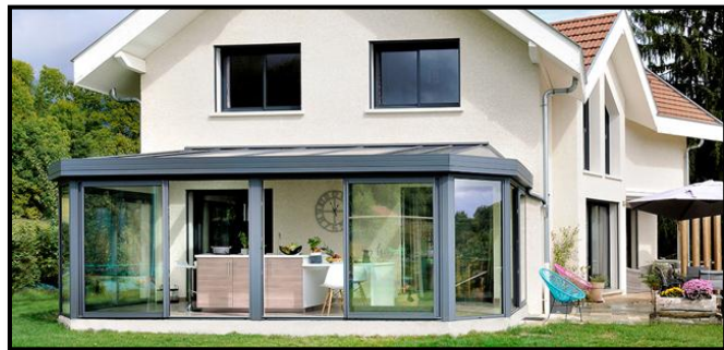
Figure 15 : Véranda attachée a une maison
