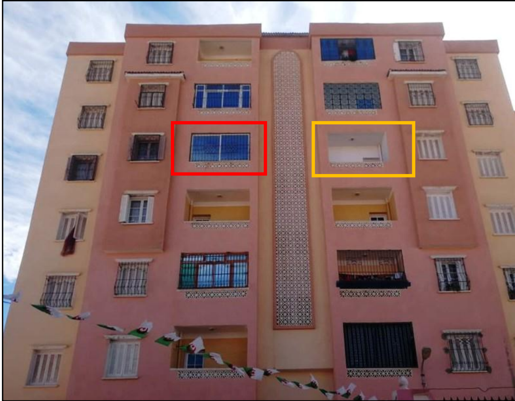
Figure 53: La cellule à loggia ouverte à droite la cellule à loggia transformée à gauche
