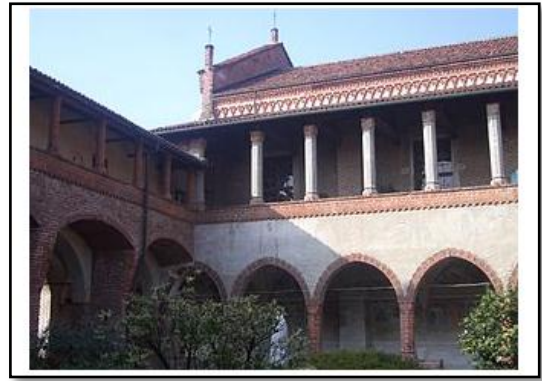
Figure 12: Exemple d'un bâtiment romain qui contient une double loggia autour d'une cour privée en Italie
