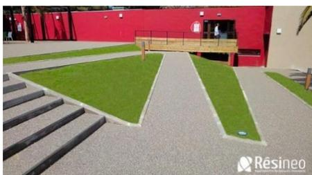
**Figure 71 : Escalier en gravier résine**
