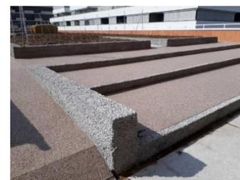
**Figure 72 : Escalier en gravier résine**
