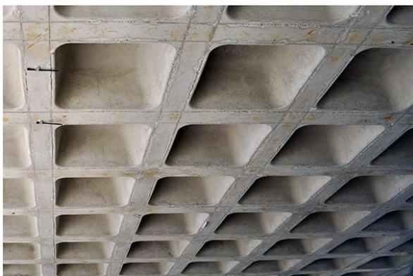
Figure 85 : Plancher caisson
