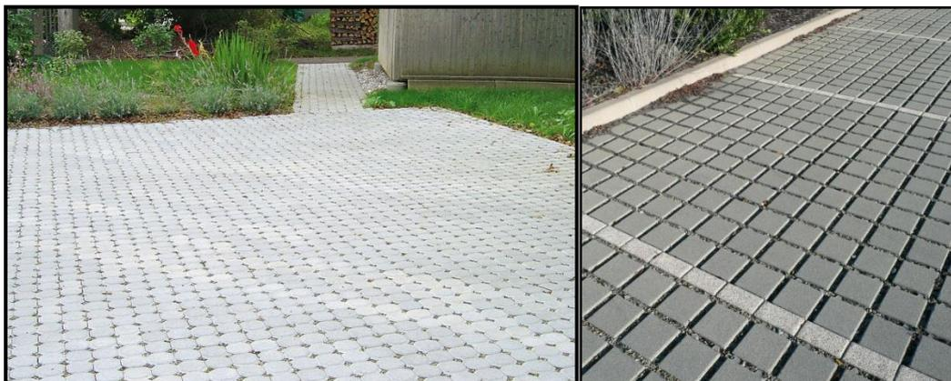
**Figure 70 : Pavé en béton drainant**
