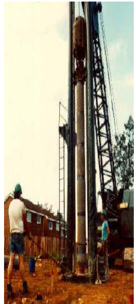
Figure 8 : Pieu battu moulé
