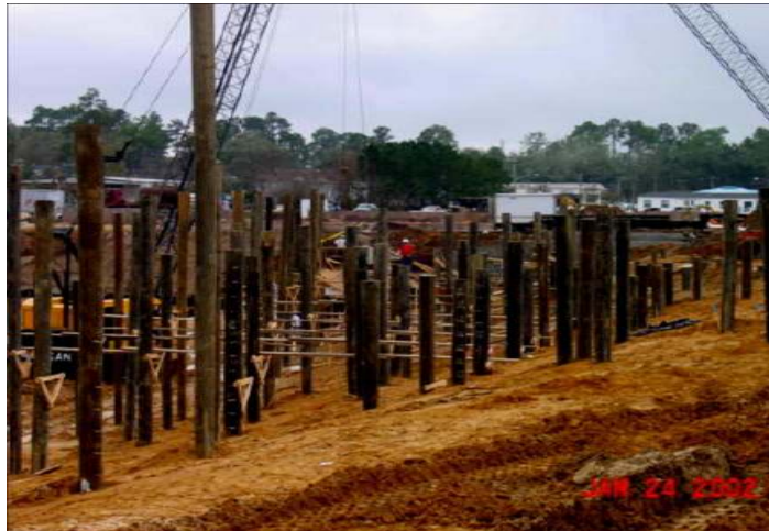
Figure 4 : Les pieux en bois
