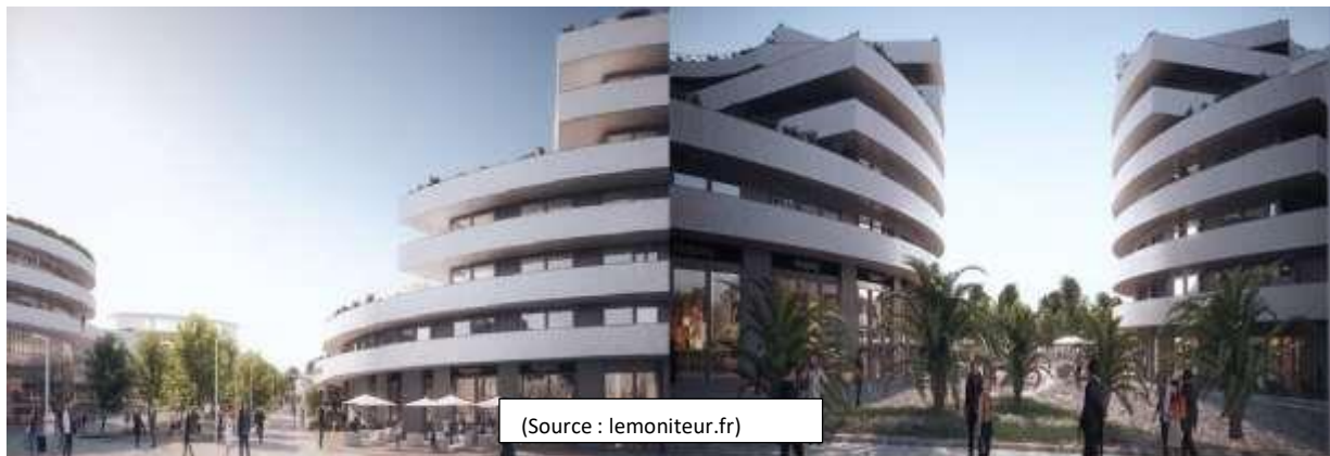
Figure 37 : Des vues montrent la façade de l'ICONIC
