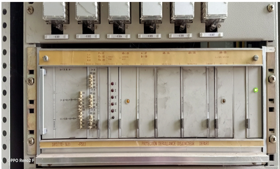
Figure III. 3. Protection de défaillance disjoncteur
