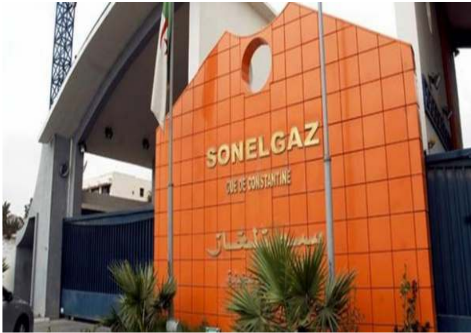
Figure 1.1 :Direction générale « SONELGAZ ».
