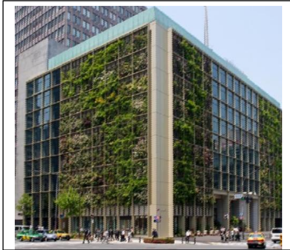
Photo 01 : Bâtiment PASONA02 Source : www.treehugger.com/.../07/pasona_o2_urban.php
