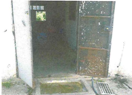
Photo 5: pédiluve à l'entrée de nursery. (photo personnelle)
