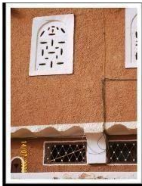
Figure3.37: La forme de protection solaire de Tafilelt .Texture rugueuse Source: http://tafilelt.com/
