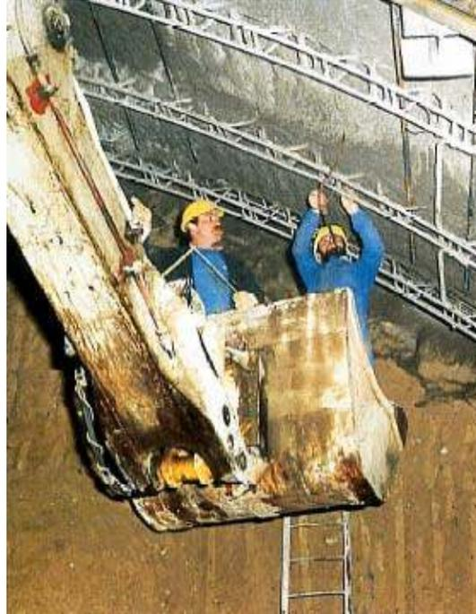
Figure.1.14 Mise en place du cintre réticulé
