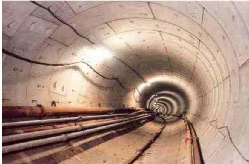
Figure.1.20. Exemple de revêtement par voussoirs en béton
