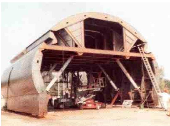
Figure.1.22 Exemple de coffrage de tunnel
