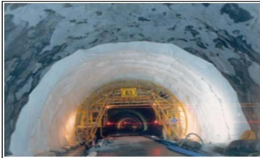
Figure.1.24. Etanchéité d'un tunnel
