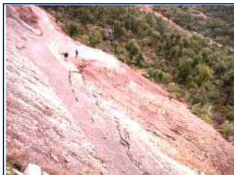
**Figure I.14** Fissures longitudinales dans la route affectée par le glissement
