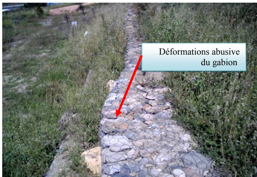
**Photo IV.5** Rupture du gabionnage
