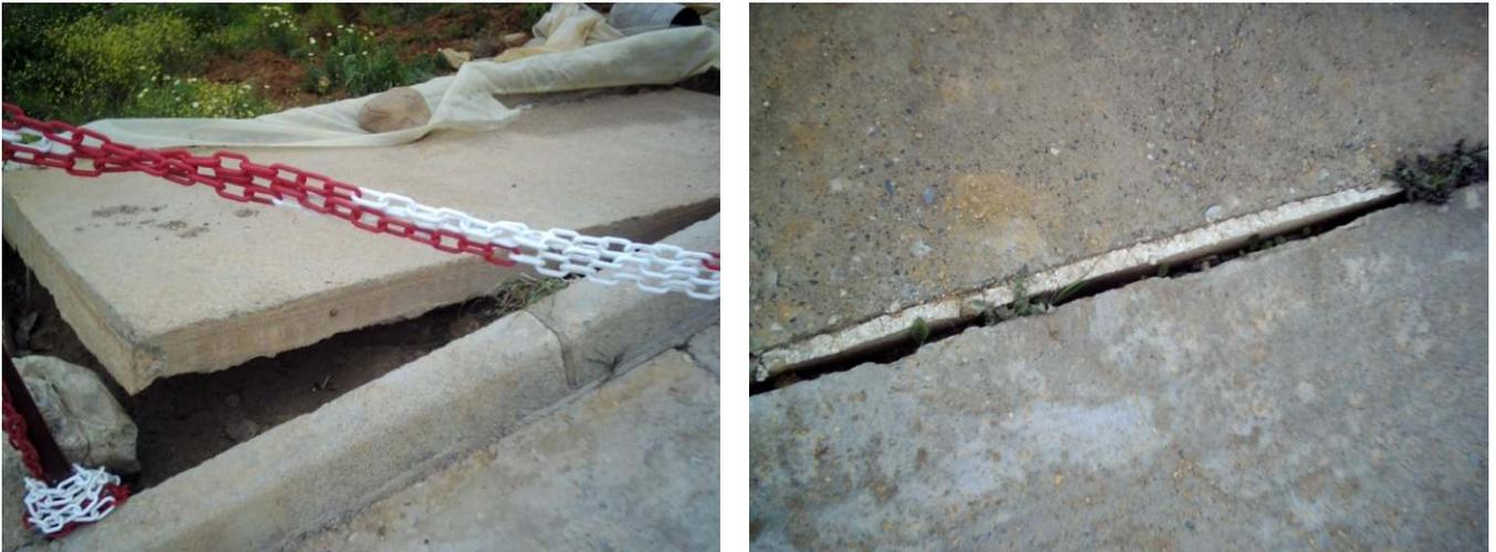
**Photo IV.2** Fissures de tractions sur l'accotement de la route.
