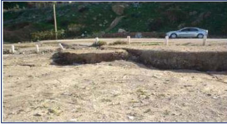
**Figure I.16** Affaissement de plus de 50cm du glissement en bas du talus (Les routes des Abattoirs Ténès).
