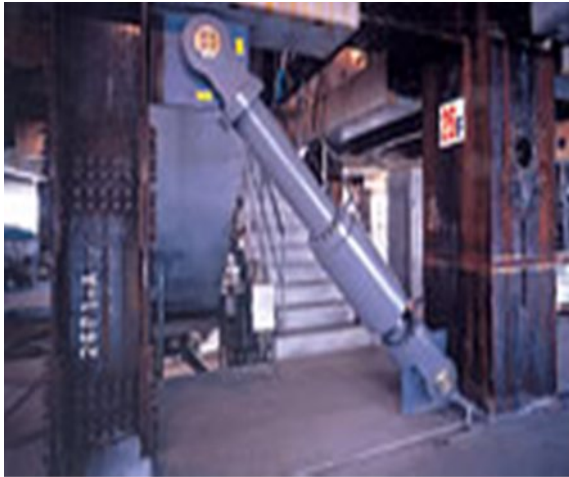
Fig (I.25) L'amortisseur visqueux qui équipe le Prudential Tower à Tokyo, (source Mori)
