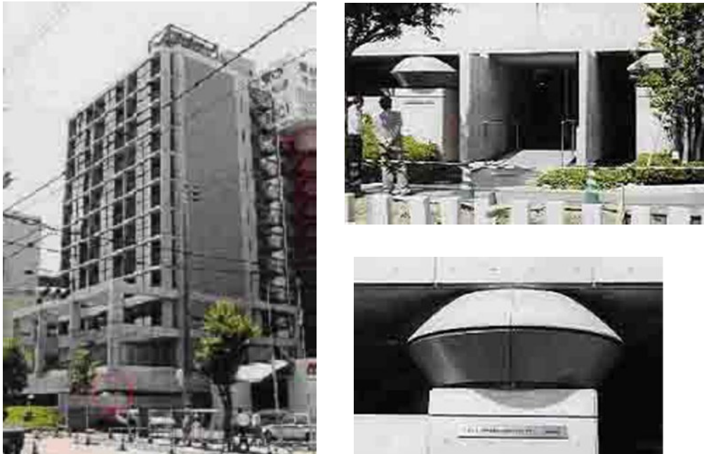
Fig (I.20). Isolation après mise aux normes
