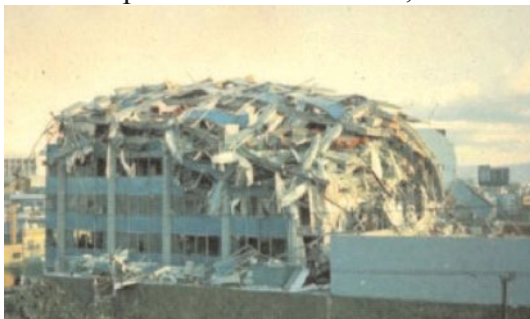
Fig (I.15) - Dommages dus à la résonance du bâtiment avec le sol Mexico, séisme 1985/09/19
