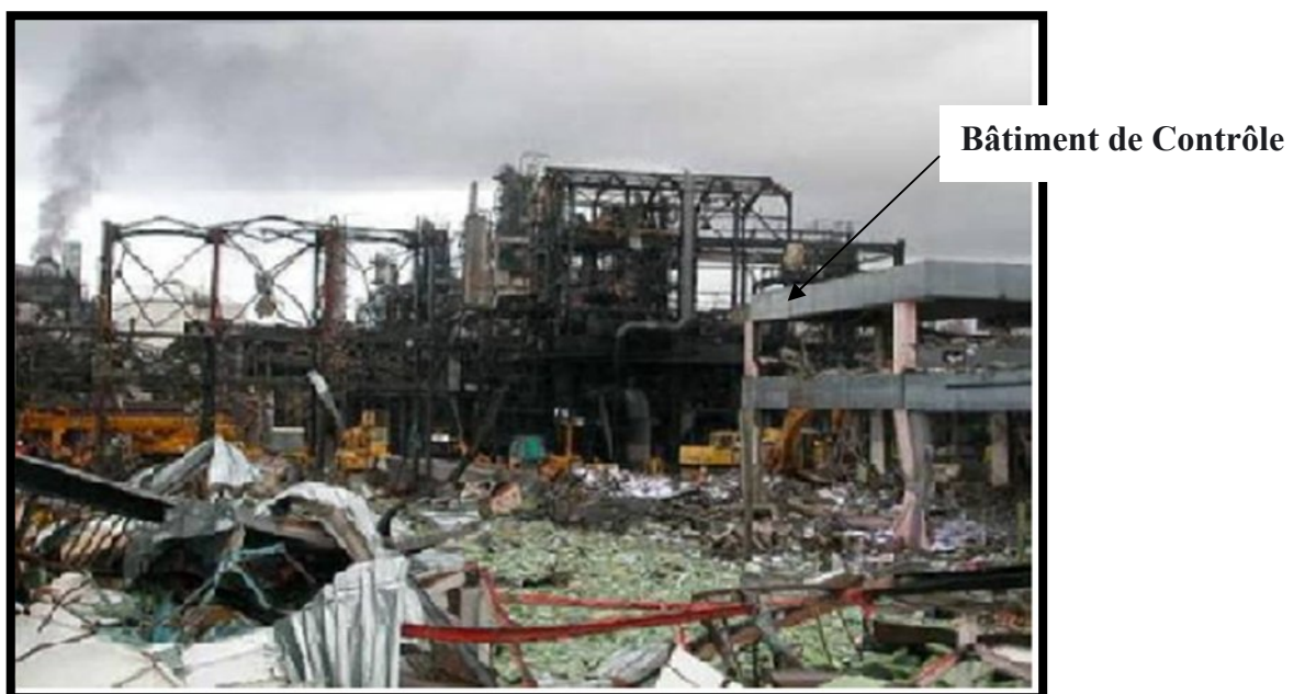
Fig. I.5.1.2 Bâtiment de Contrôle endommagé ii) Accident Belgique 2004
