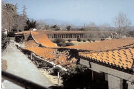
a) Charpente lourde portée par des murs en maçonnerie non chaînée
