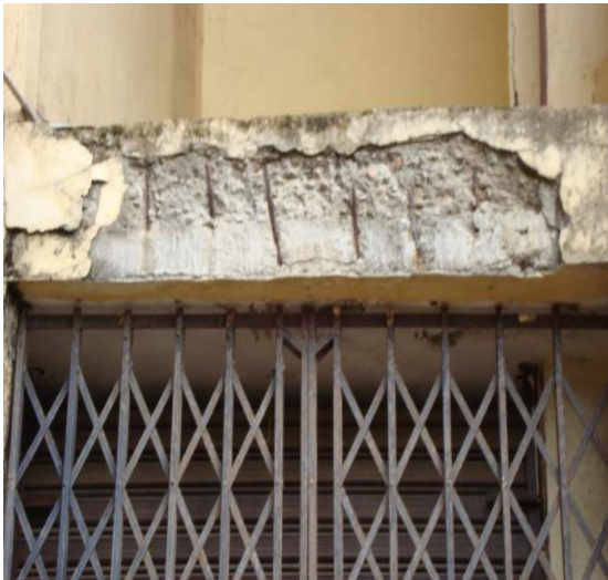
Figures 12 & 13: Corrosion des aciers par manque d'enrobage
