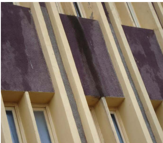
Figures 14 & 15 : Ruissellement des eaux pluviales sur les linteaux
