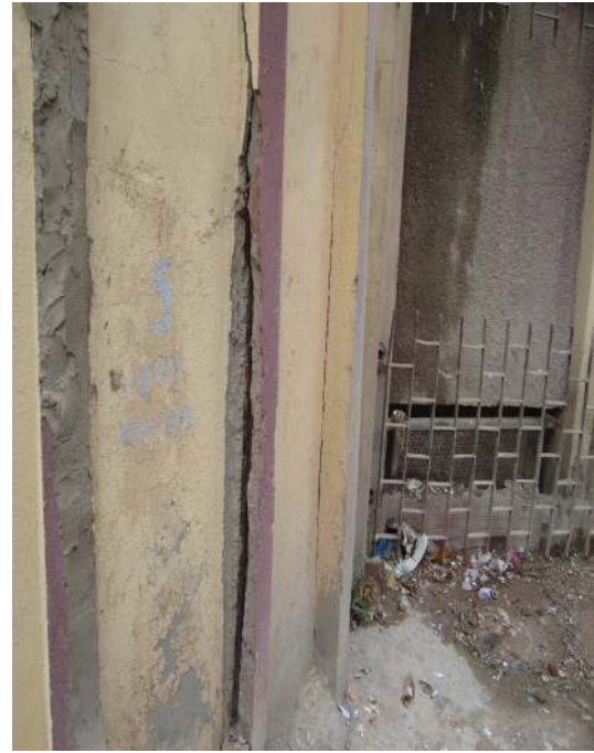
Figures 4 & 5 : Corrosion et éclatement du béton des escaliers externes (côté sud) du bloc principal
