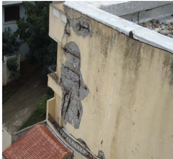
Figures 12 & 13: Corrosion des aciers par manque d'enrobage
