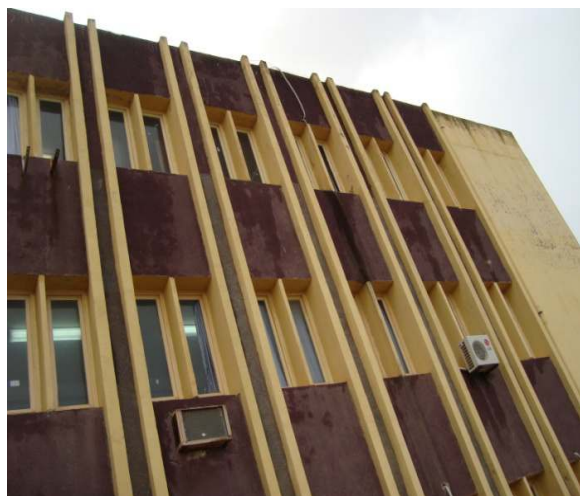
Figures 14 & 15 : Ruissellement des eaux pluviales sur les linteaux
