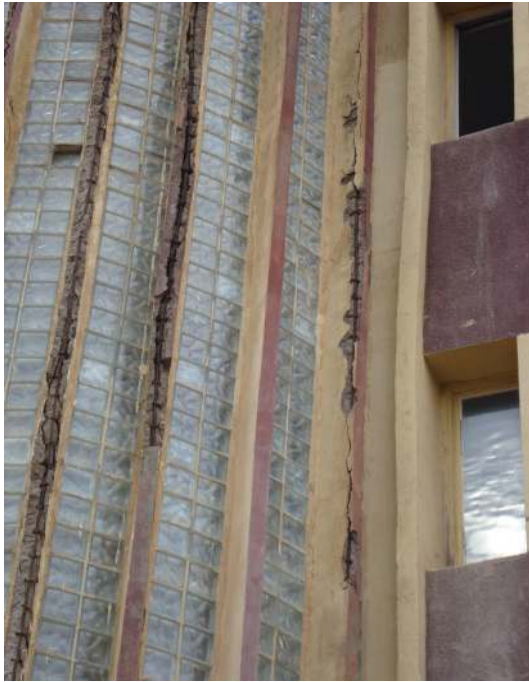
Figures 4 & 5 : Corrosion et éclatement du béton des escaliers externes (côté sud) du bloc principal
