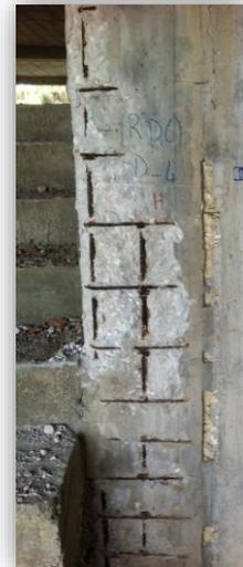
Corrosion des armatures et Eclatement du béton
