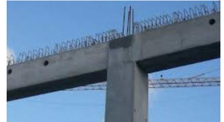
Figure 101: Système en poteau/poutre
