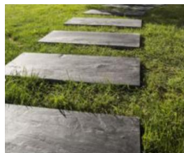
Figure 114: revêtements de sol permettant l'infiltration naturelle des eaux de ruissellement vers le nappe phréatique
