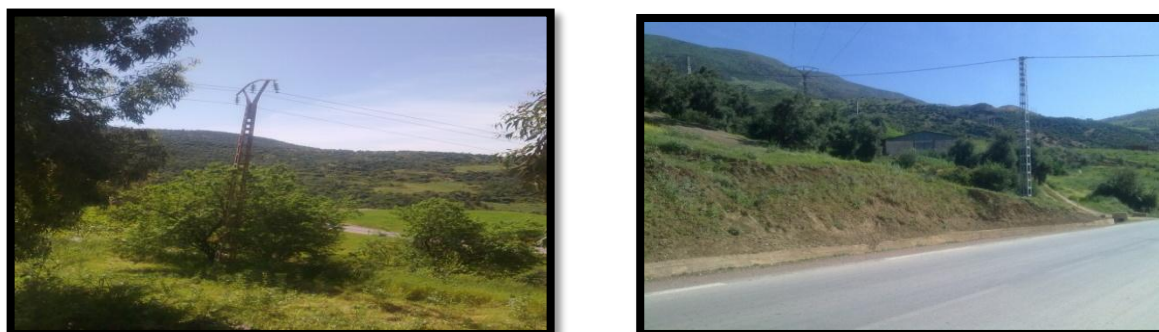
Figure 67: photos de Poteaux électrique de moyenne tension
