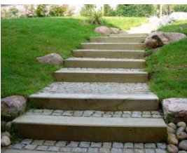
Figure 114: revêtements de sol permettant l'infiltration naturelle des eaux de ruissellement vers le nappe phréatique
