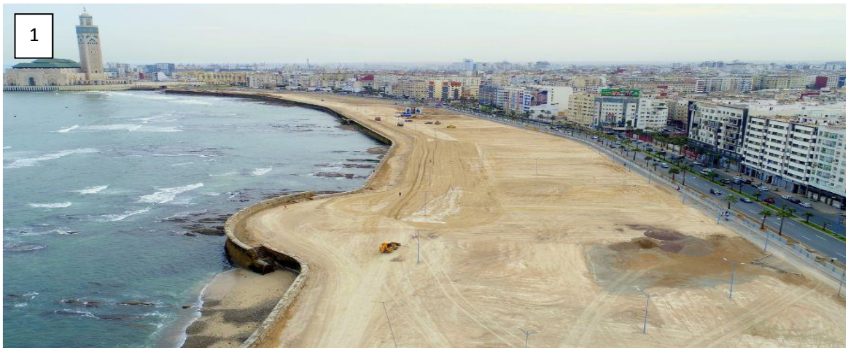
Figure 31 :vue sur la promenade maritime Hassan II de Casablanca .
