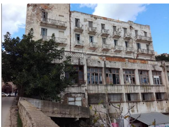
Bâtit en mauvaise
