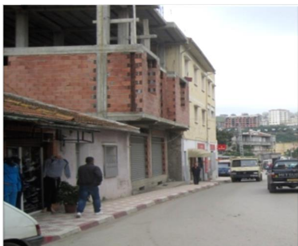
Bâtit en cours de construction
