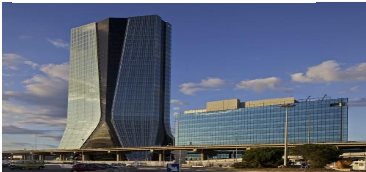
Figure 39 : vue sur la tour CMA-CGM .
