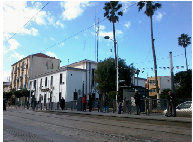
Figure 3.24 : Arrêt Tramway Bordj El Kiffan Centre
