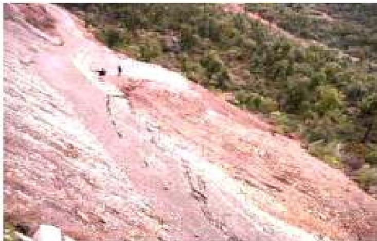
*Photo. I.5 : Fissures longitudinales dans la route affectée par le glissement*
