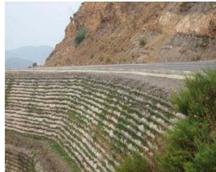
*Photo III.2: remblai avec la géosynthétique*
