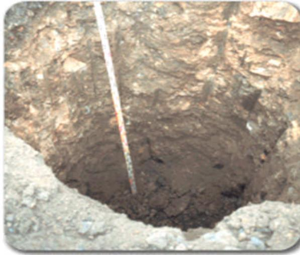
Figure 2.7: Plot ballasté avant remblaiement [15]
