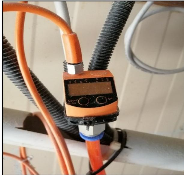
**Figure II.10:** Capteur de pression ifm de type PQ
