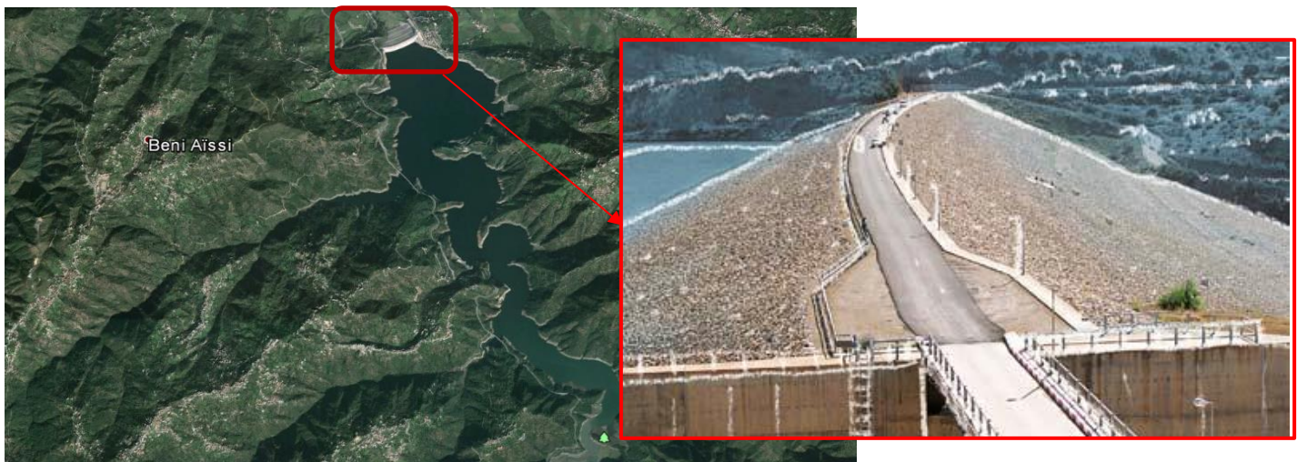
Figure 13-Vue aérienne sur le barrage de Taksebt
