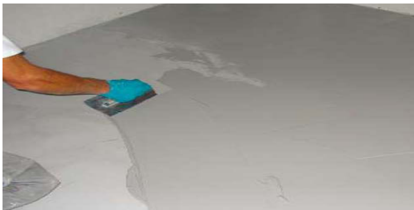
Figure 1.7 : Pose de la seconde couche
