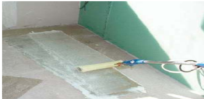
Figure 1.5 : application de la colle sur le support
