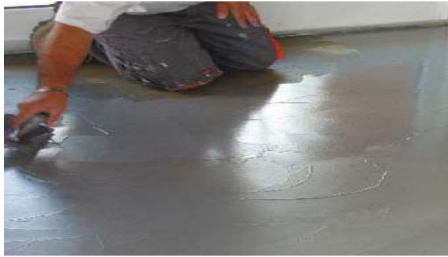
Figure 1.6 : Pose de la première couche
