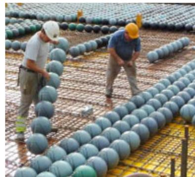
Figure 198 : Une prise pendant la réalisation du plancher Cobiax.
