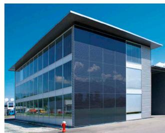
Figure 174 : Panneaux photovoltaïques sur façades
