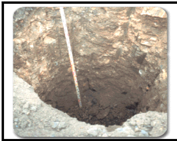
Figure II-7: Plot ballasté avant remblaiement[15]
