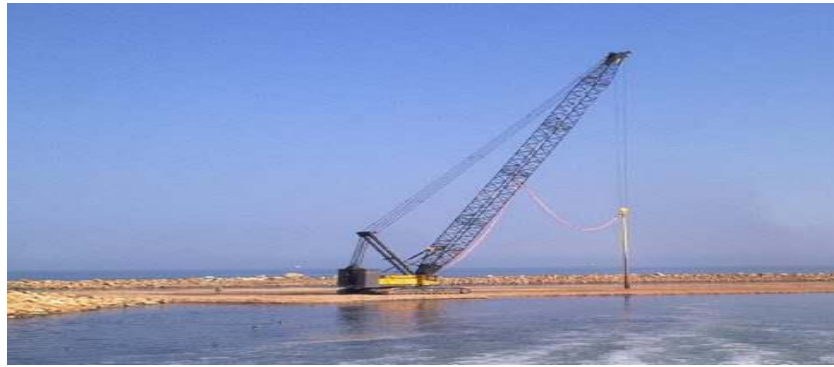
Figure II-1: Compactage par vibroflottation[18]
