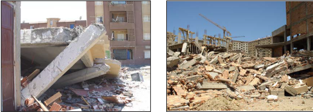
Figure 2.2: Effondrement total de constructions en BAMR (Boumerdès 2003).
