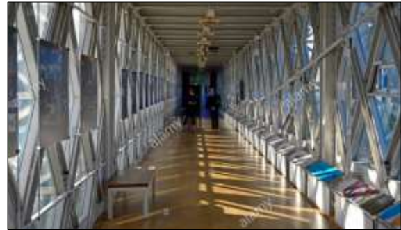
Figure17 : Tower Bridge passerelle Londres
