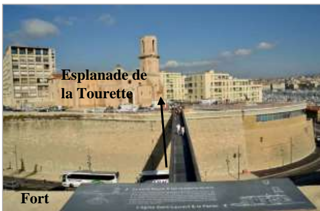
Figure34: La 2eme passerelle qui relie le fort à l'esplanade de la Tourette
