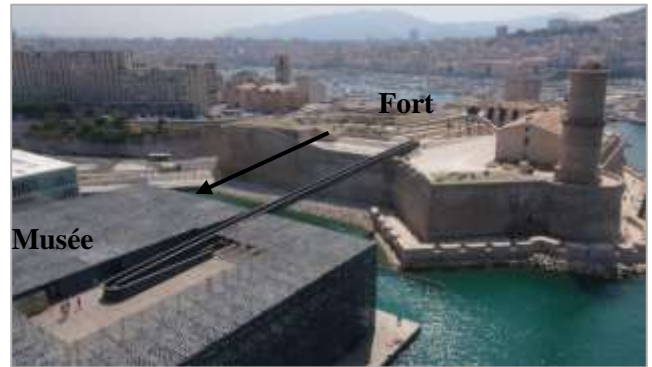
Figure33: La 1ere passerelle qui relie le fort au musée
