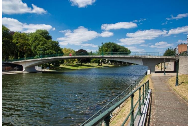
Figure2.12 : Pont Hennebique où Mativa à Liège
