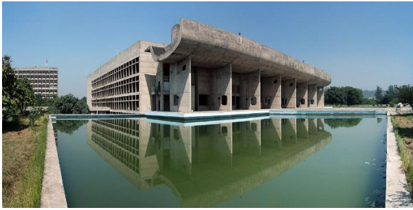
Figure 3.18: Palais des Assemblées du Pendjab
