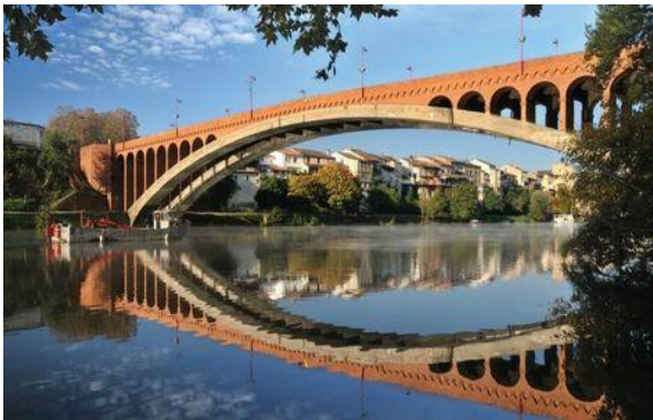
Figure 2.31 : Pont de la Libération Villeneuve-sur-Lot
