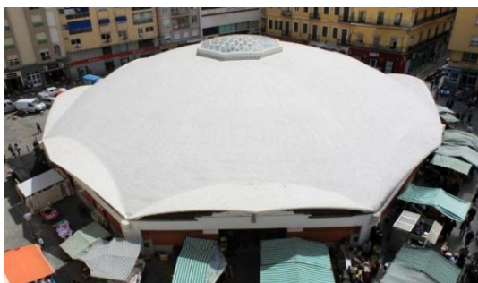
Figure2.36 : Couverture du Marché central d'Algésiras
