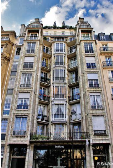
Figure2.23 : Immeuble locatif 25 bis
