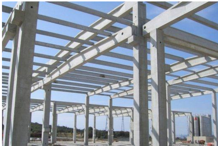
Figure1.20 : Charpente préfabriqué en béton armé et précontraint
