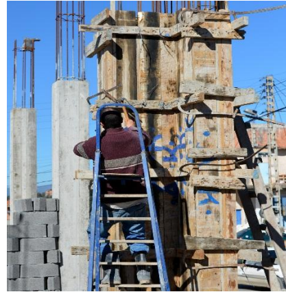
Figure1.18 : Coffrage d'un élément
