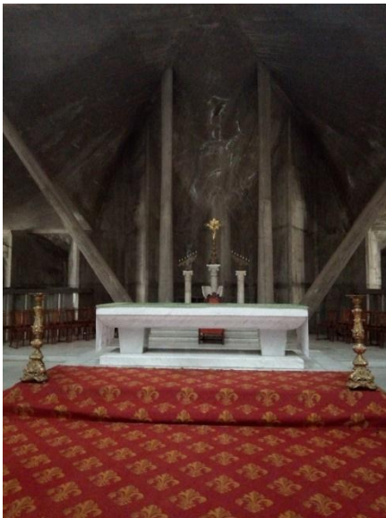
Figure 6.8 : Le narthex et chœur sont fermés par des murs en béton armé
