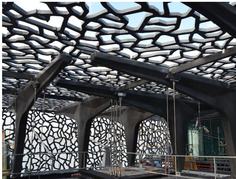
Figure1.25 : Colonnes et panneaux en dentelles en béton haute performance.
