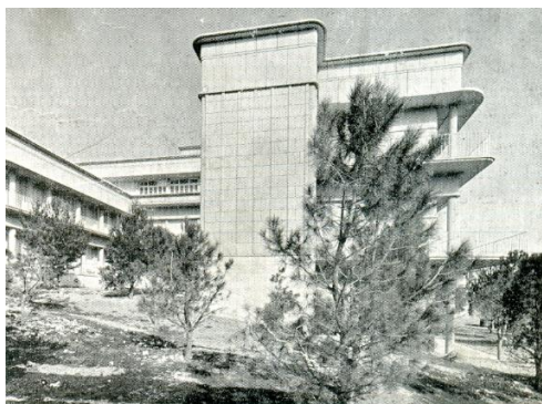
Figure 5.28 : Mur en élément moulé
