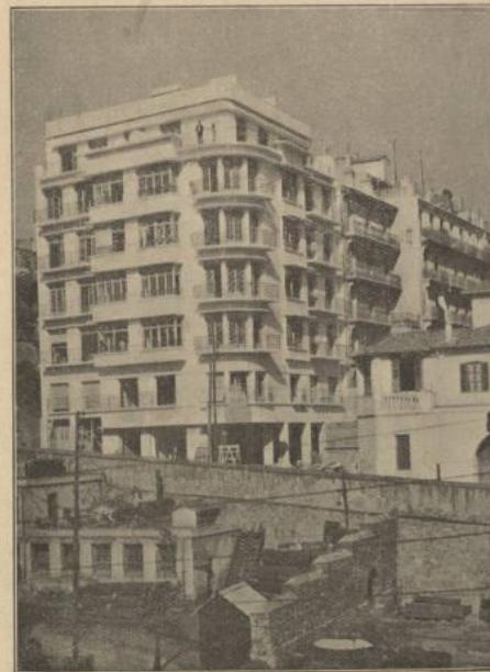
Immeuble, boulevard Edgard Quinet, à Alger. — Vue d'ensemble (Bétons armés Hennebique) (Ph. de Louvencourt, Alger)
