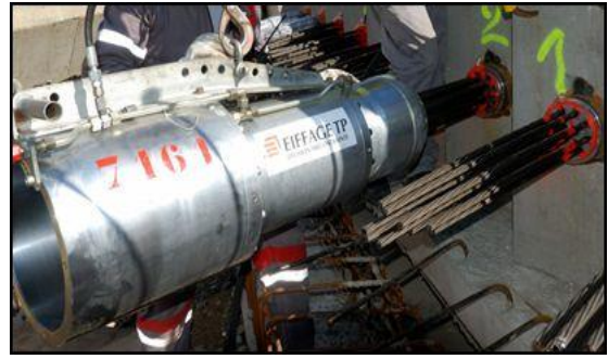
Figure1.24 : Mise en place d'un vérin.
