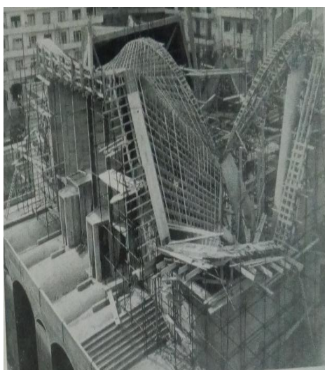
Figure.6.4 : Vue de l'ouvrage en construction
