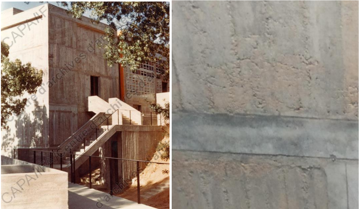
Figure 5.52 : Béton banché utilisé dans le centre culturel
