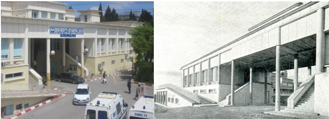
Figure 5.25 : Entrée principal par le bâtiment d'accueil entre passé et présent
