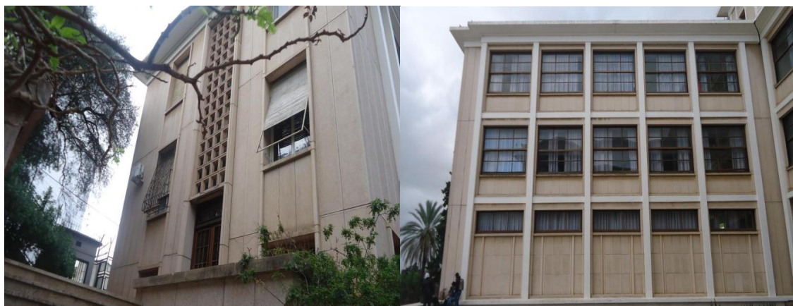
Figure 5.46 : La mise en valeur de la structure sur les façades
