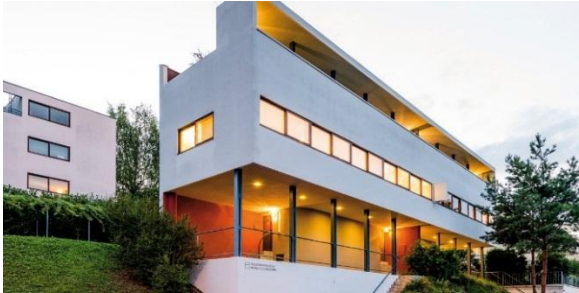
Figure 3.9 : La cité weissenhofsiedlung
