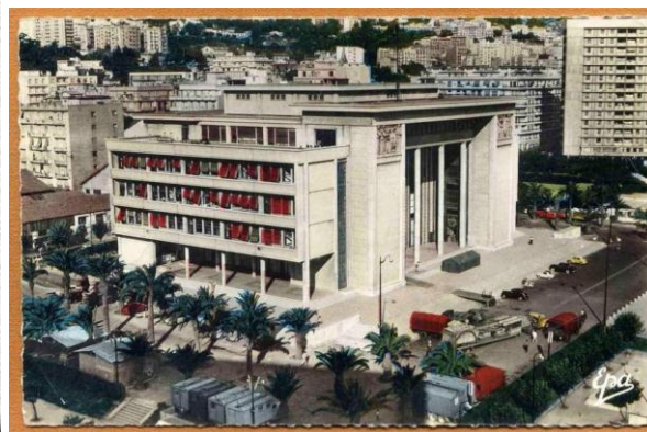
Figure 5.20 : Photographie montrant les pilotis et l'entrée
