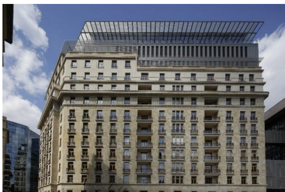
Figure2.34 : La Résidence Palace à Bruxelles
