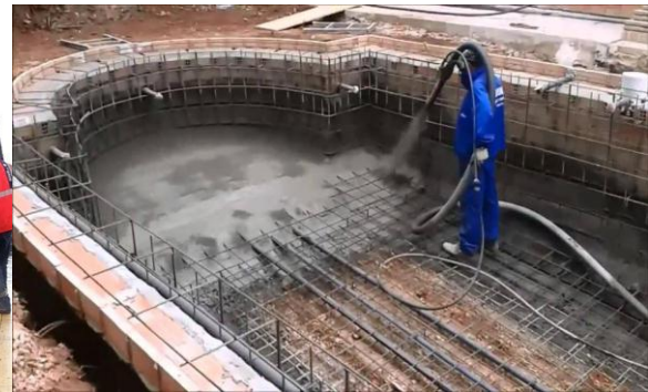
Figure1.29 : Béton projeté pour une piscine
