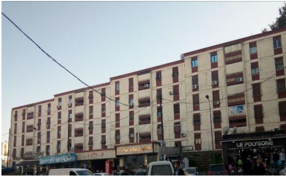
Figure 4.3: Vue sur la façade postérieure de la cité Diar El Afia
