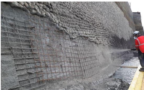
Figure1.28 : Béton projeté pour un mur de soutènement.
