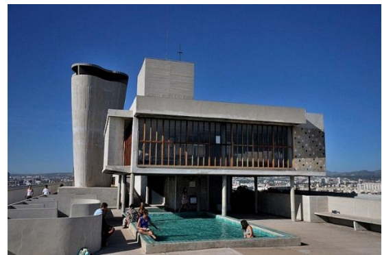
Figure 3.12 : le toit terrasse de la cité Radieuse.
