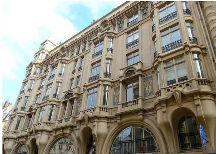
Figure2.7 : Immeuble de bureau Hennebique
