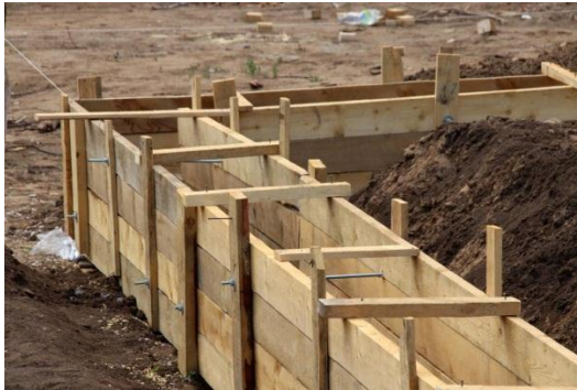
Figure1.19 : Coffrage des éléments horizontaux fondation et plancher de dalle
