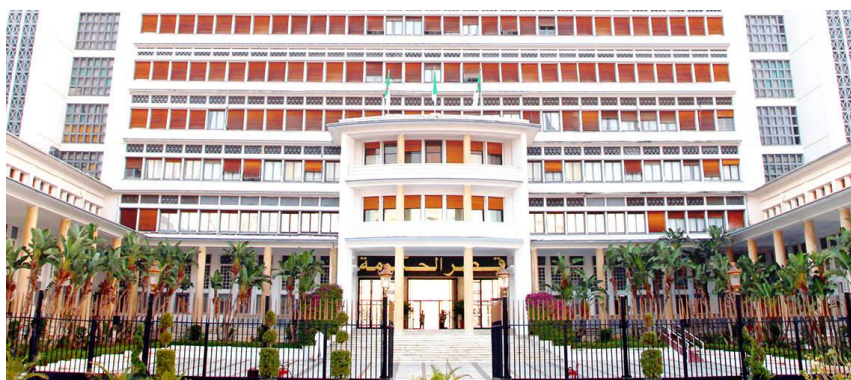
Figure 5.3 : Vue sur la cour d'honneur
