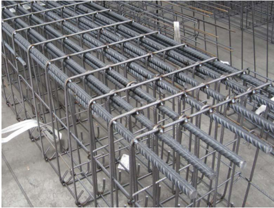
Figure1.17 : Cages des armatures verticale (poteau)
