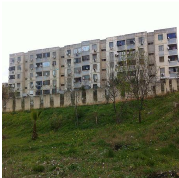
Figure 4.12: Vue sur la façade de la cité El Bir
