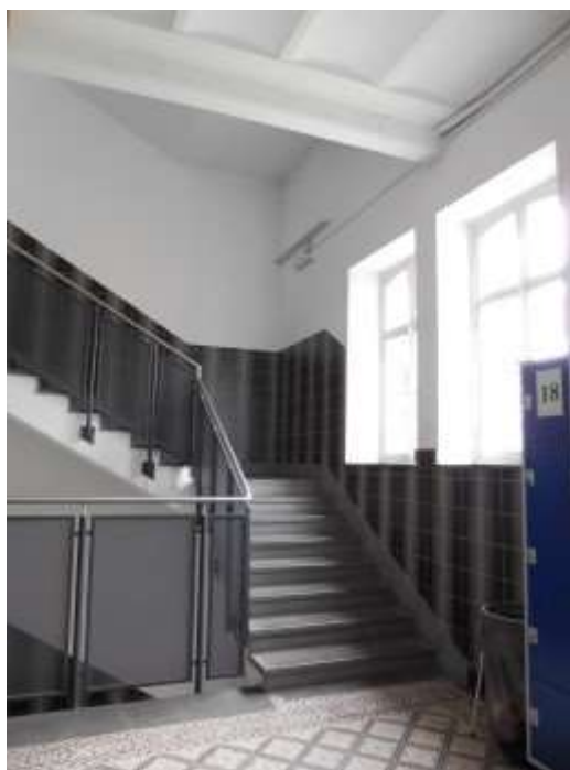
Figure 7.18 : Revêtement spécifique de teinte foncée pour la cage d'escalier minimise les salissures [72].
