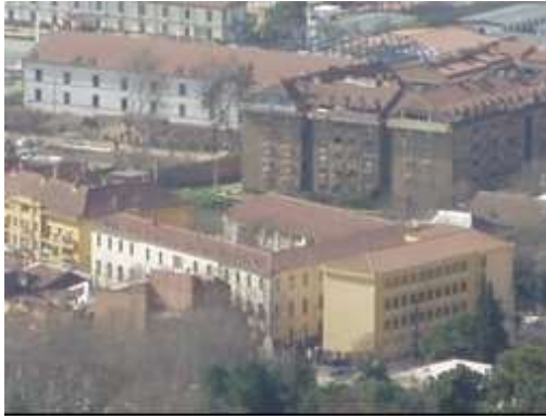
a) Vue extérieure de l'enveloppe du lycée.
