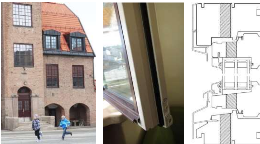
Figure 7.7 : Exemple de nouvelles fenêtres « maison passive » [37].
