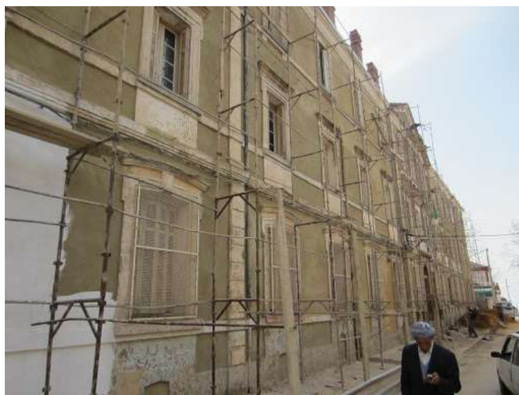
Figure 7.3 : Application d'enduit ciment sur murs extérieurs du lycée ABDOU [111].
