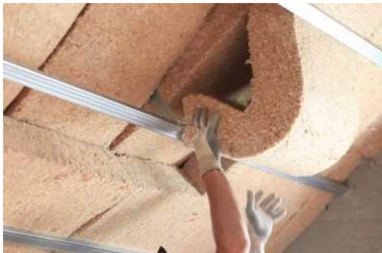
Figure 7.2 : Isolation par laine de bois en rouleaux du plancher d'un grenier [140].
