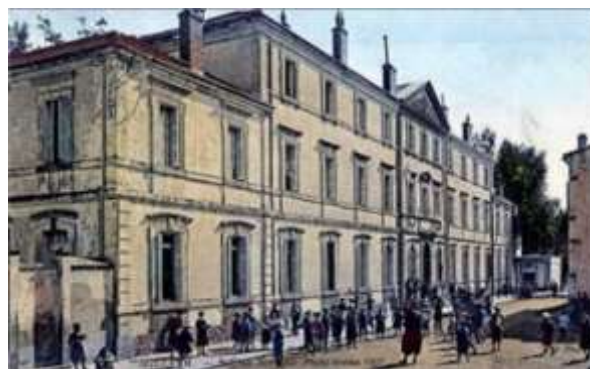
b) Façade principale construite dans un style néo-classique 1874 [111].
