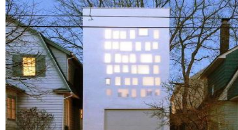
Figure 70 : La maison Haffende Source : designboom.com
