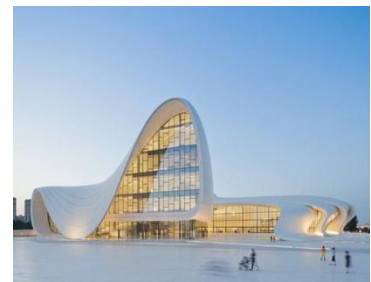
Figure 90 : Le Centre HeydarAliyev
