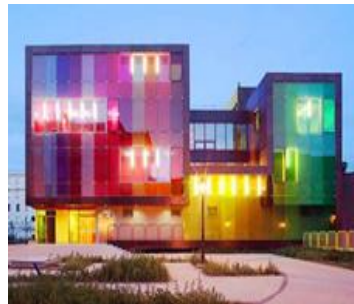
Figure 86 : Le ruban centre de loisirs Saint-Cloud 92
